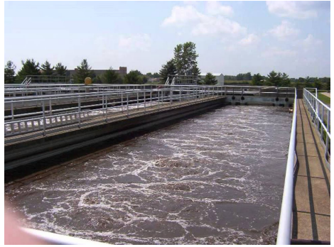
บ่อบำบัดน้ำเสีย
