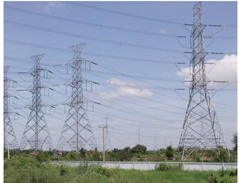
เสาไฟฟ้า
