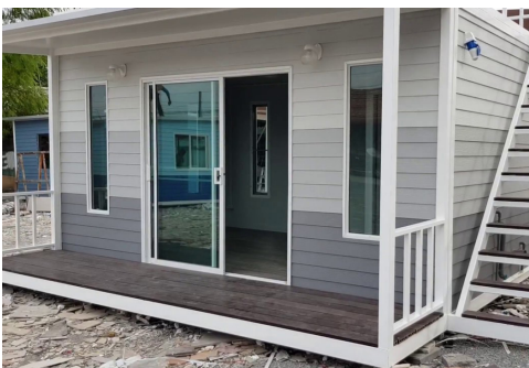
บ้านประกอบเสร็จ
